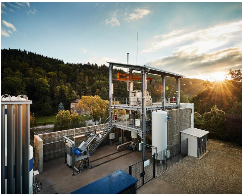
SuSteel Pilotanlage in Donawitz Foto © voestalpine AG
