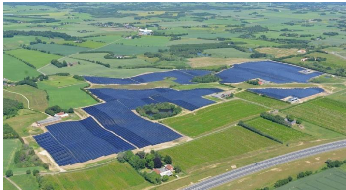
Weltweit größte solarthermische Anlage bei Arcon-Sunmark in Silkeborg/ Dänemark © GREENoneTEC
