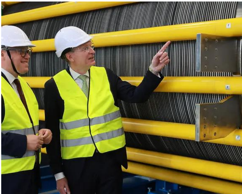
Електролізний штабель на заводі ANDRITZ Erfurt © Зображення: ANDRITZ
