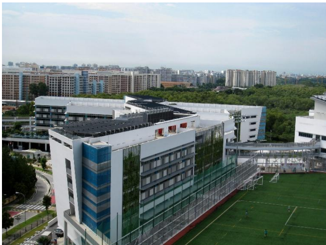
新加坡世界联合学院的太阳能供暖和制冷，照片 ©: SOLID
