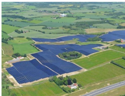
Weltweit größte solarthermische Anlage in Dänemark mit 156.694 m 2
