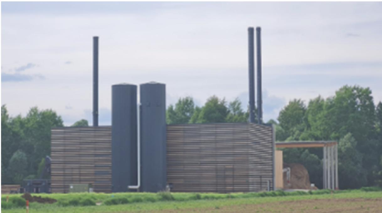
**Abbildung 110 – Ansicht des 2023 in Betrieb gegangenen Heizwerks Wollsdorf in der Steiermark, inklusive der beiden jeweils 200 m<sup>3</sup> fassenden Großwärmespeicher**
