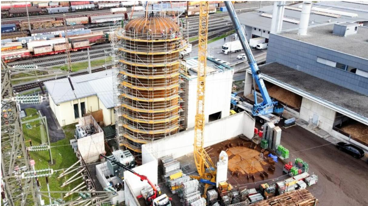
**Abbildung 112 – Errichtung des Großwärmespeichers in Hall in Tirol mit 1.400 m<sup>3</sup> und 97 MWh thermische Kapazität mit Fertigstellung im Dezember 2022**
