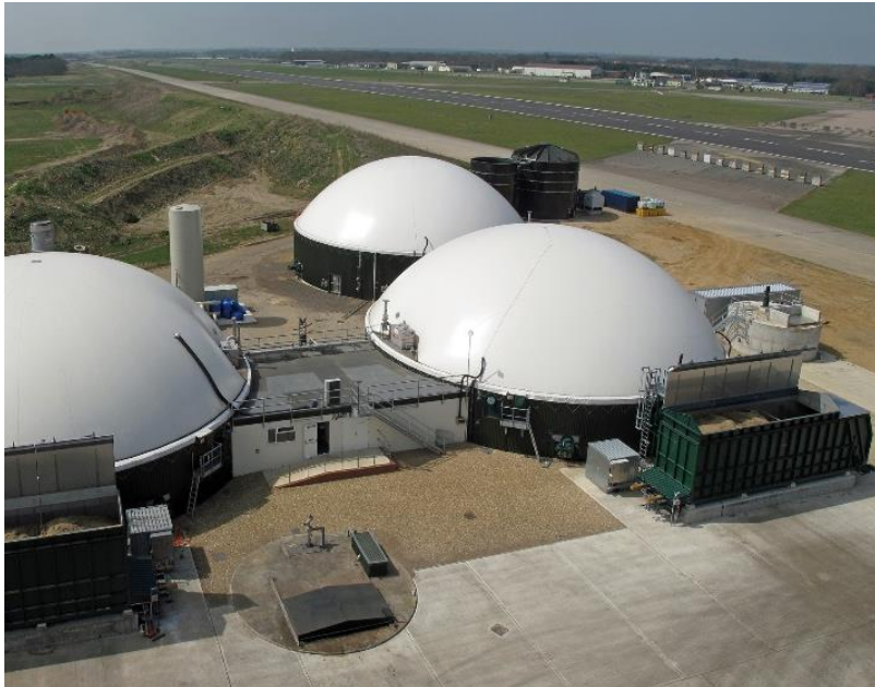
Thöni Industriebetriebe; biogas plant in the UK
