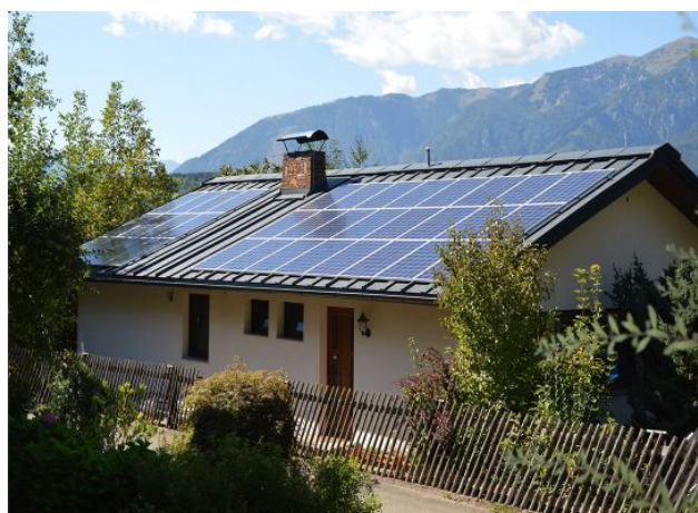
Energieverbrauch 2021 (Gesamtsystem) Photovoltaik 11,7 kWp mit Batterie 12 kWh
