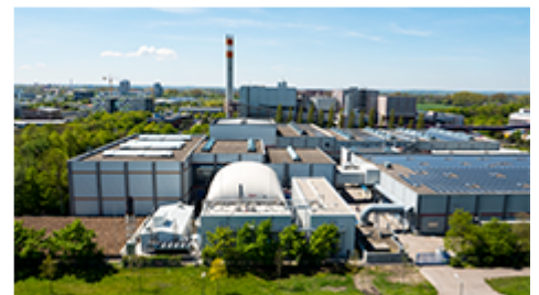
Thöni Trockenvergärungsanlage in Augsburg
