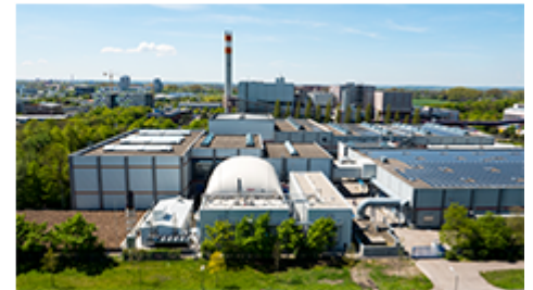
Thöni Trockenvergärungsanlage in Augsburg
